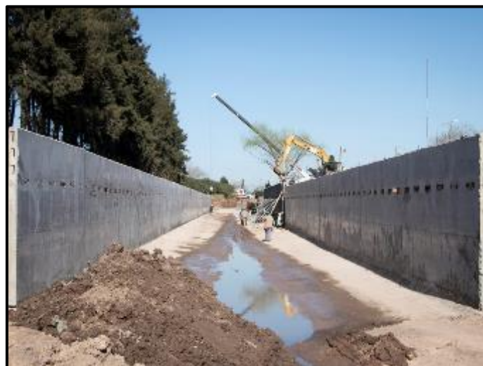
Figura 118: Saneamiento hidráulico de Arroyo Los Perros
